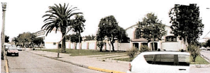
FACHADAS CALLE CANTOURNET
