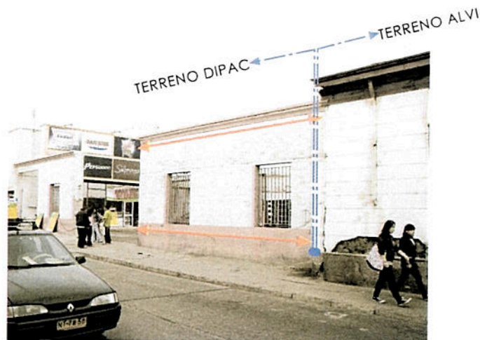
SITUACIÓN ACTUAL / SUPERMERCADO DESLINDA CON FACHADA DE DIPAC POR CALLE VICENTE ZORRILLA
