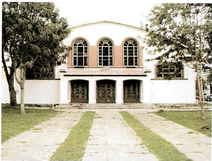
FACHADAS CALLE CANTOURNET
